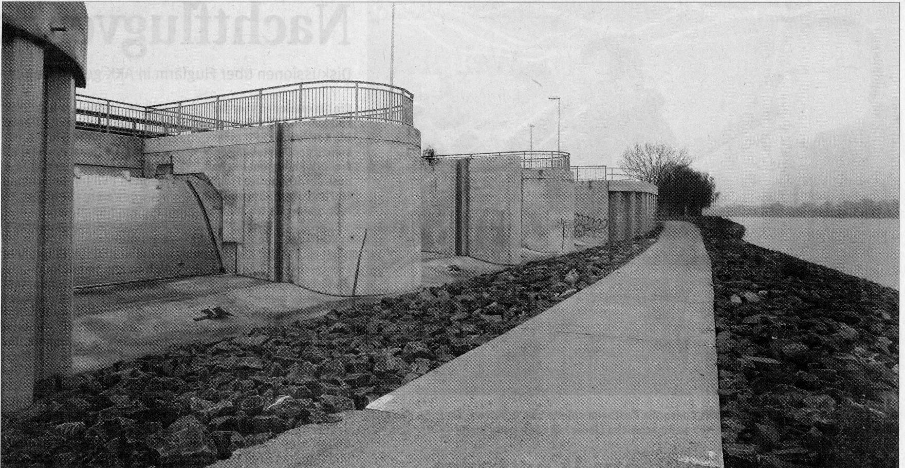
30 Meter lang ist das Auslassbauwerk, auf dem die B 9 entlang führt. Wenn der Rhein zu voll wird, öffnen sich die Tore und der Polder füllt sich. ■ Fotos: Bernd Eßling
